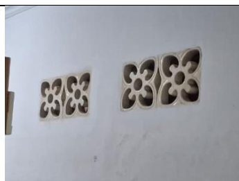
Terdapat ventilasi digudang
